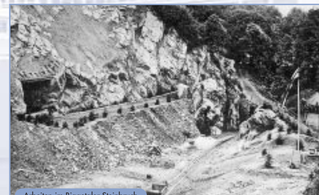
Arbeiten im Biggetaler Steinbruch
