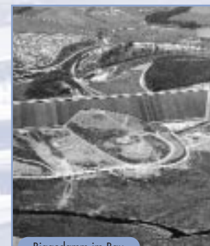
Biggedamm im Bau
