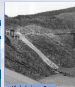
Überlaufrichter im Bau
